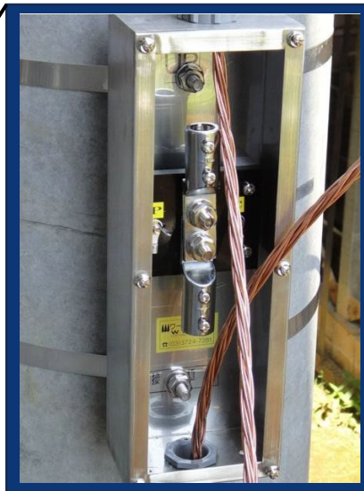
試験用端子箱と端子
