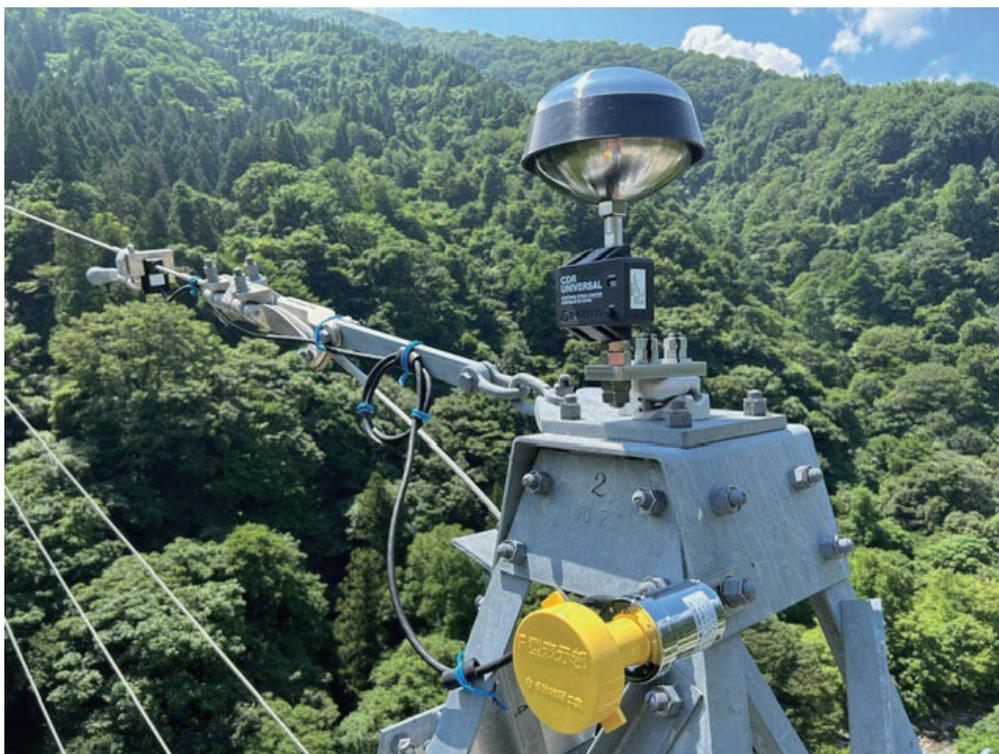
送電鉄塔上部のPDCE-junior。雷サージカウンターと閃絡表示機©も設置
