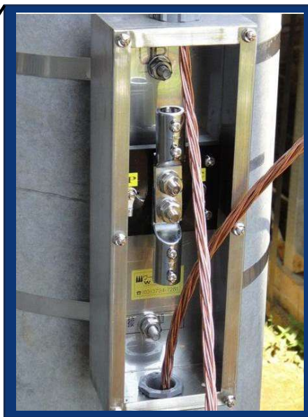
試験用端子箱と端子
