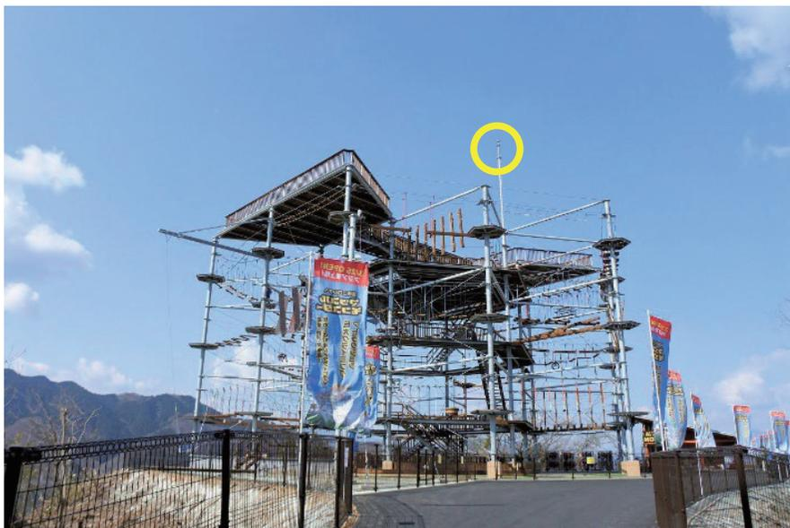
マッスルモンスターに取り付けられた PDCE 避雷球 [Magnum]。点検用足場付ポールの高さは 7 m。直径 24 c m の Magnum が小さく見える
