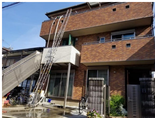
自宅内部の水損は、外観からは窺い知れない
