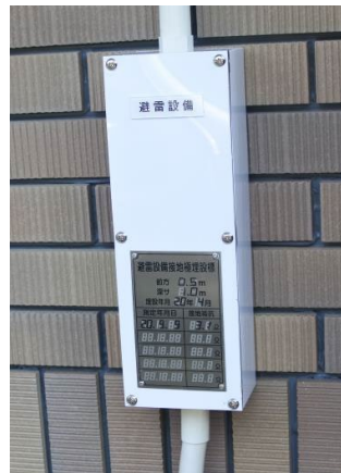
アースの接地工事もばっちり
